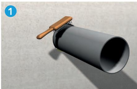
1 Nettoyer le tube au niveau de l'ouverture de la cloison afin d'obtenir une surface lisse et sans poussière.
