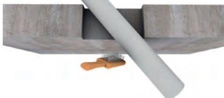
Nettoyer le tube au niveau de l'ouverture de la cloison afin d'obtenir une surface lisse et sans poussière.
