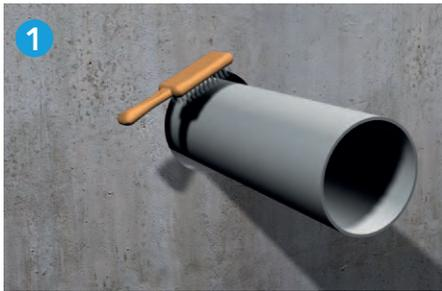
1 Nettoyer le tube au niveau de l'ouverture de la cloison afin d'obtenir une surface lisse et sans poussière.
