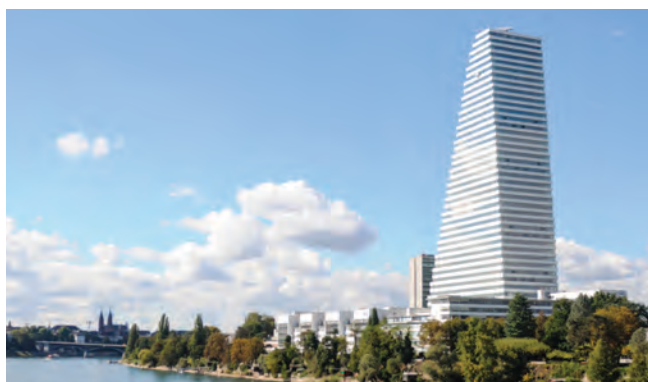
Roche-Turm (Bau 1), Basel
