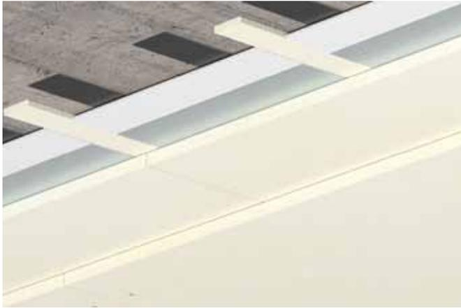
Si plusieurs lamelles sont revêtements ensemble, plus l'apport de chaleur par le béton est faible. Par conséquent, les plafonds totales ou partielles peuvent généralement être plaquées plus finement que les lamelles uniques.
