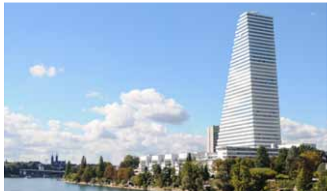
Roche-Turm (Bau 1), Basel
