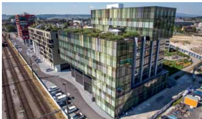
Überbauung Suurstoffi, Rotkreuz
