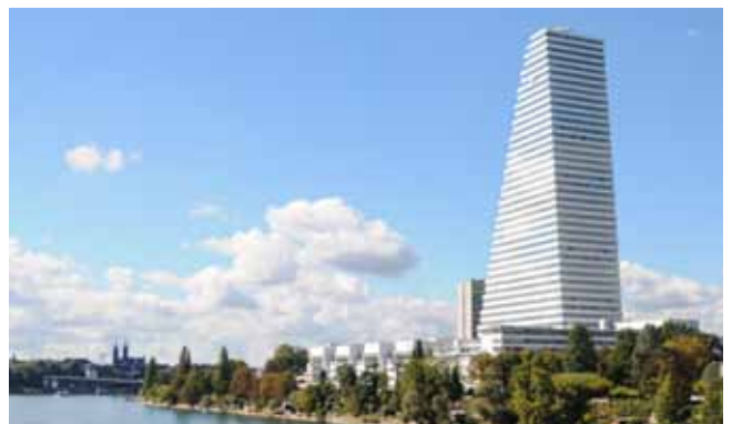
Roche-Turm (Bau 1), Basel
