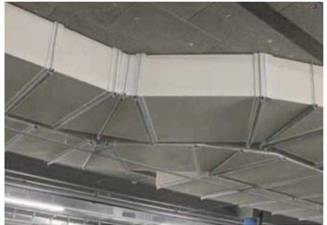
**Einzelabschnitt „single“** wird nach EN 1366-9 auf eine reduzierte Temperatur z.B. 600° C geprüft, die Wärmedämmung (I) wird nicht gemessen.
