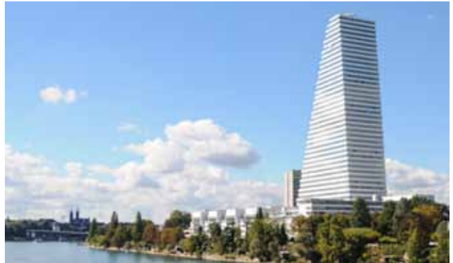
Roche-Turm (Bau 1), Basel
