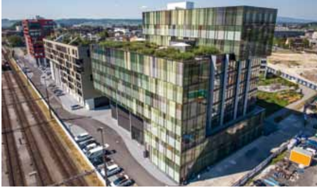
Überbauung Suurstoffi, Rotkreuz
