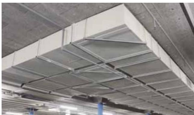
Les conduits de désenfumage et d'extraction de chaleur se différencient des conduits d'aération par la durée de fonctionnement et les exigences. Par ex.: sections uniques ou multiples, pression, durée d'utilisation, etc.
