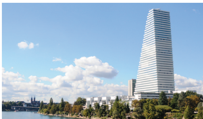
Roche-Turm (Bau 1), Basel
