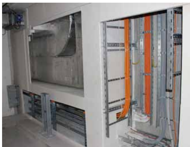
Paroi de la gaine technique
