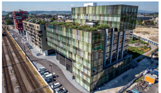
Überbauung Suurstoffi, Rotkreuz
