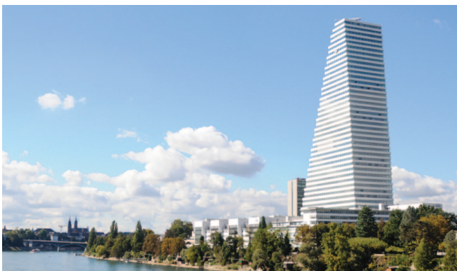
Roche-Turm (Bau 1 + 2), Basel
