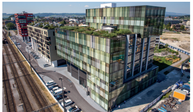
Überbauung Suurstoffi, Rotkreuz
