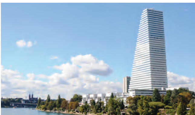
Roche-Turm (Bau 1 + 2), Basel
