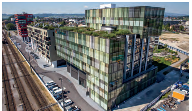
Überbauung Suurstoffi, Rotkreuz
