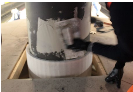
7 Stahl reinigen Promat®-Kleber K84 ( d \geq 1 \text{ mm} ) gleichmässig auf Stahl auftragen
