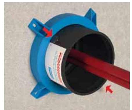
6. Direkt an das Befestigungssystem auf die Halbschalen zwei der transparenten Sticker kleben.
